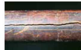
BELASTUNGSBRUCH Gefahr von Längs- oder Korngrenzenrissen durch hohe Wasserströmung
