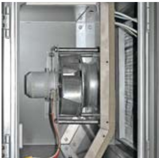
Fan section Zu- und Abluftventilator Ventilatore
