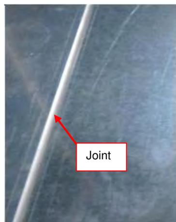
**Illustration 89** : Scellement du raccordement de section (joint) avec le matériau d'étanchéité
