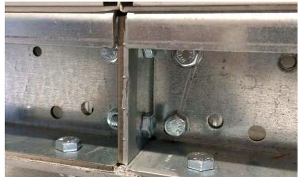
**Illustration 52** : Assemblage par boulon des châssis de base
