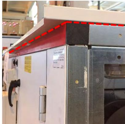
Illustration 98 : Fermeture des raccords avec du mastic
