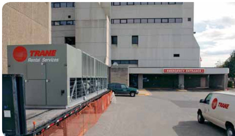
Tranes Lösungen zur Notfallkühlung beruhigen das Gewissen
