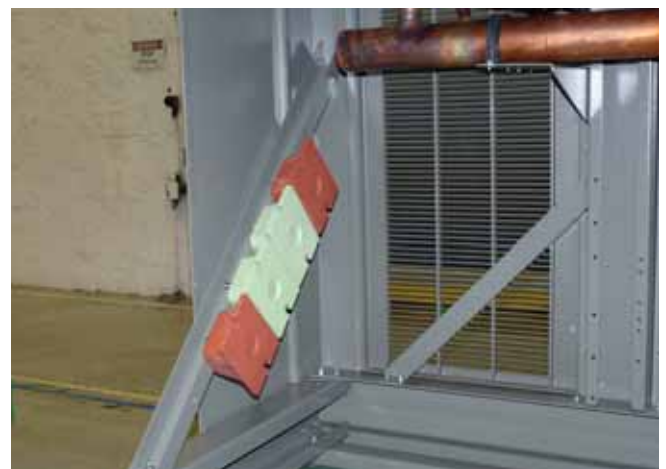
Afbeelding 4. Elastomeren dempers bevestigd ten behoeve van transport
