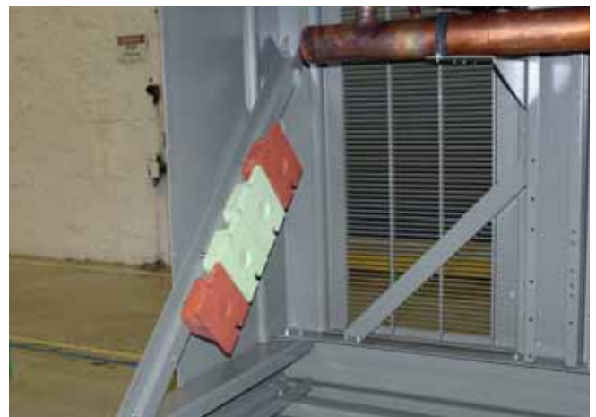
Figure 4. Amortisseurs en élastomère fixés pour l'expédition
